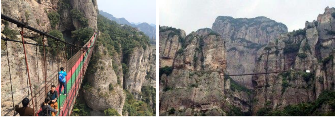
Mynd 53. Hengibrú í einhverra tuga metra hæð yfir gil á göngustígnum sem liggur eftir Ignimbrítlagninu. Sumum innlendum ferðalöngum finnst mjög gaman að hoppa á þessari brú og láta hana hristast og sveiflast, öðrum ferðalöngum til mikillar skelfingar.
